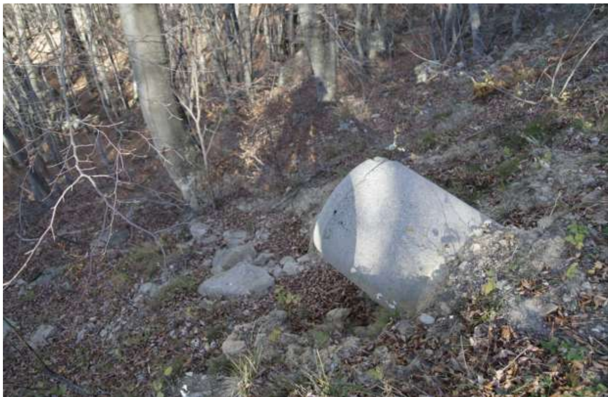
Illustrazione 22: tratto dove imbottire con pietre il recapito dell'acqua proveniente dalla canalina
