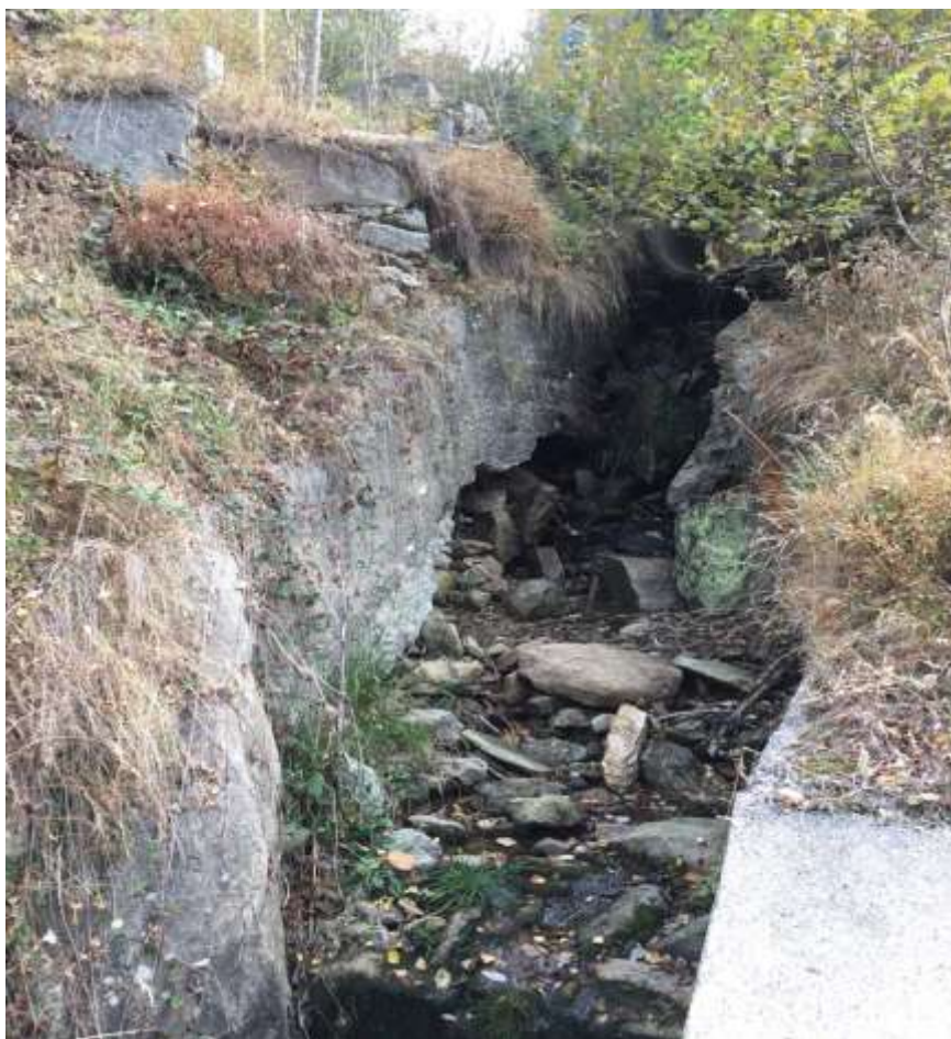
Illustrazione 17: tratto in cui la sponda risulta scalzata
