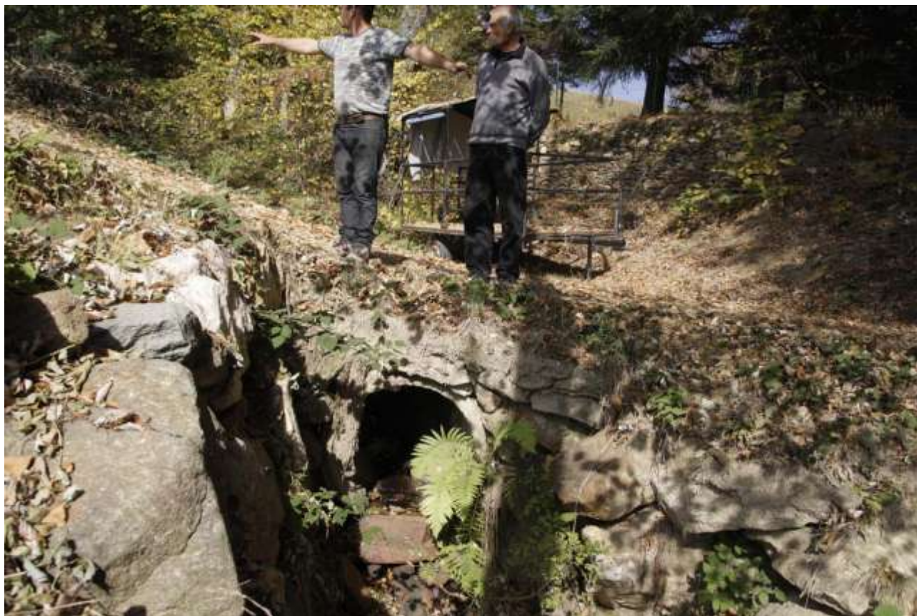
Illustrazione 3: uno dei due attraversamenti intubati con tubazione da sostituire
