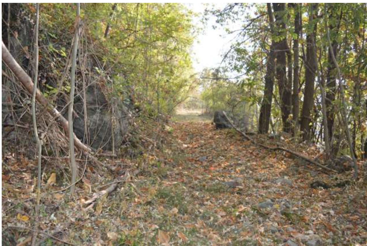
Illustrazione 11: pista forestale senza gestione delle acque superficiali
