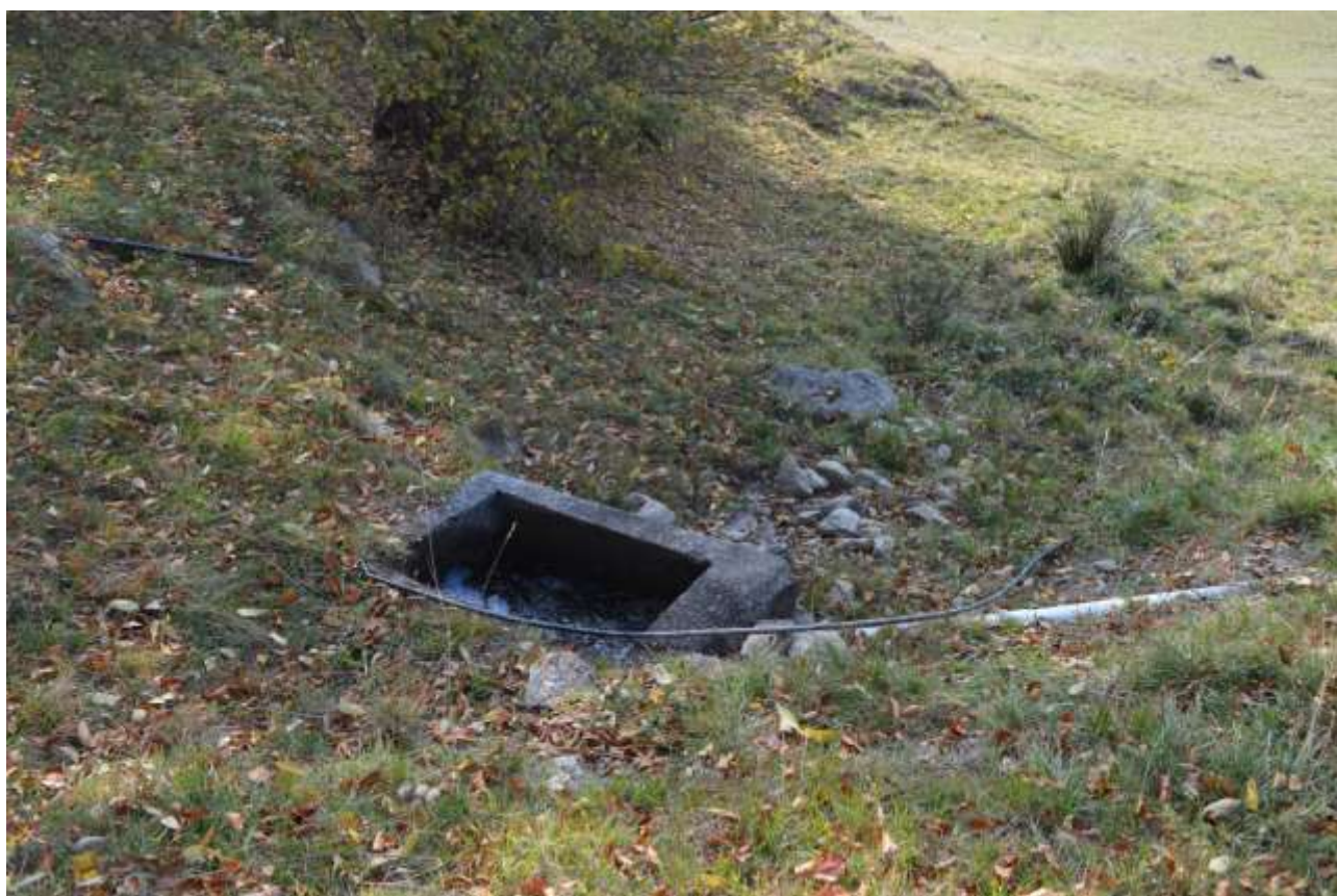
Illustrazione 10: un tombino per presa irrigua ed il canale intubato posato in superficie
